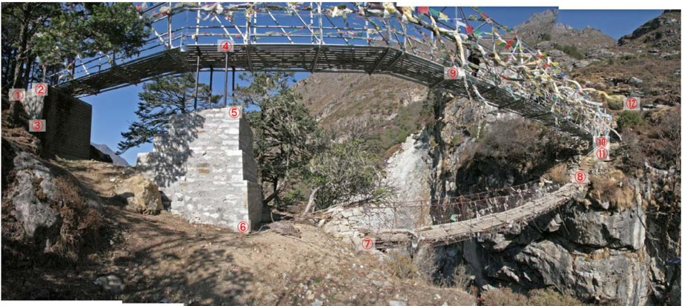
図12 パンボチェの橋付近の河川断面形状の計測のための目標点の設定
